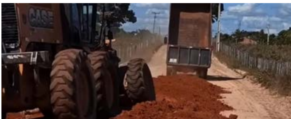
As máquinas preparam a estrada para receber a camada asfáltica
