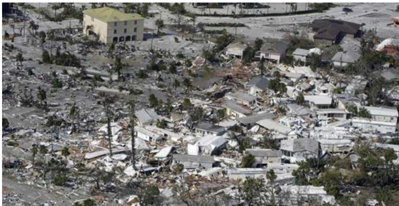
Casas destruídas pelo furacão Ian em Fort Myers, na Flórida — Foto: Wilfredo Lee/AP
