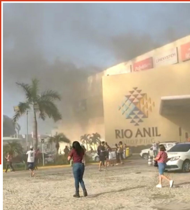
O incêndio teria começado na Sala de Cinema
