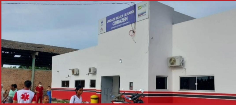
Atendimentos já estão sendo realizados na UBS Cibrazém
