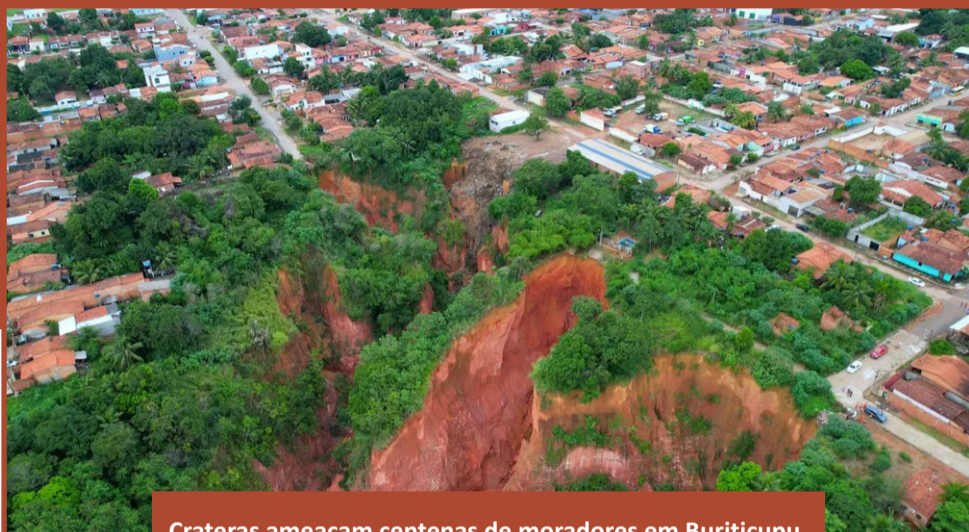
Crateras ameaçam centenas de moradores em Buriticupu, no Maranhão — Foto: Reprodução/Marinho Drones
